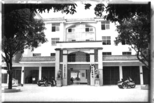
市建设局办公楼
